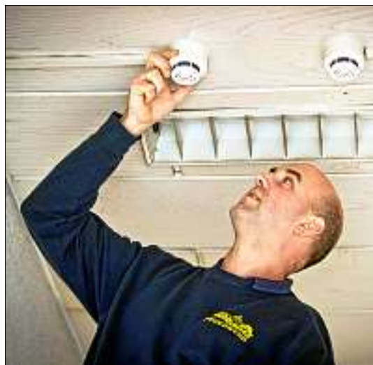
Feuerwehrmann André Thon kontrolliert Rauchmelder auf der Mühlhäuser Wache. Foto: Daniel Volkmann
